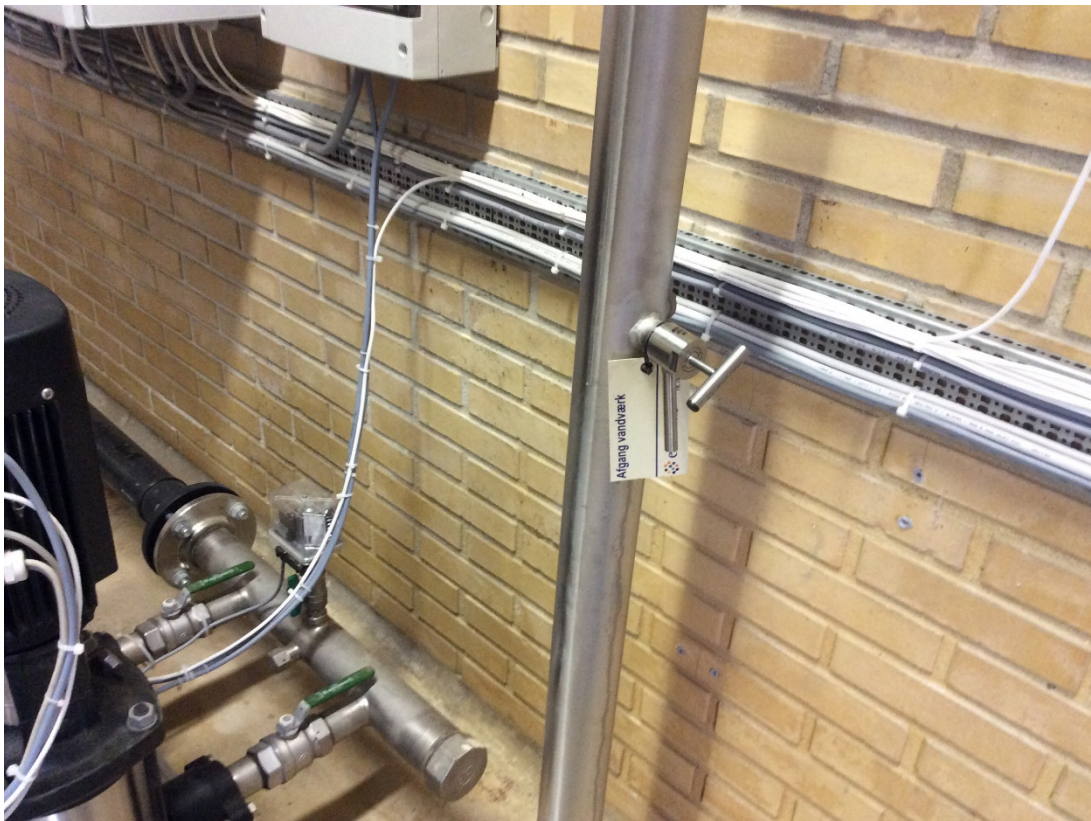
Prøvehane afgang vandværk
