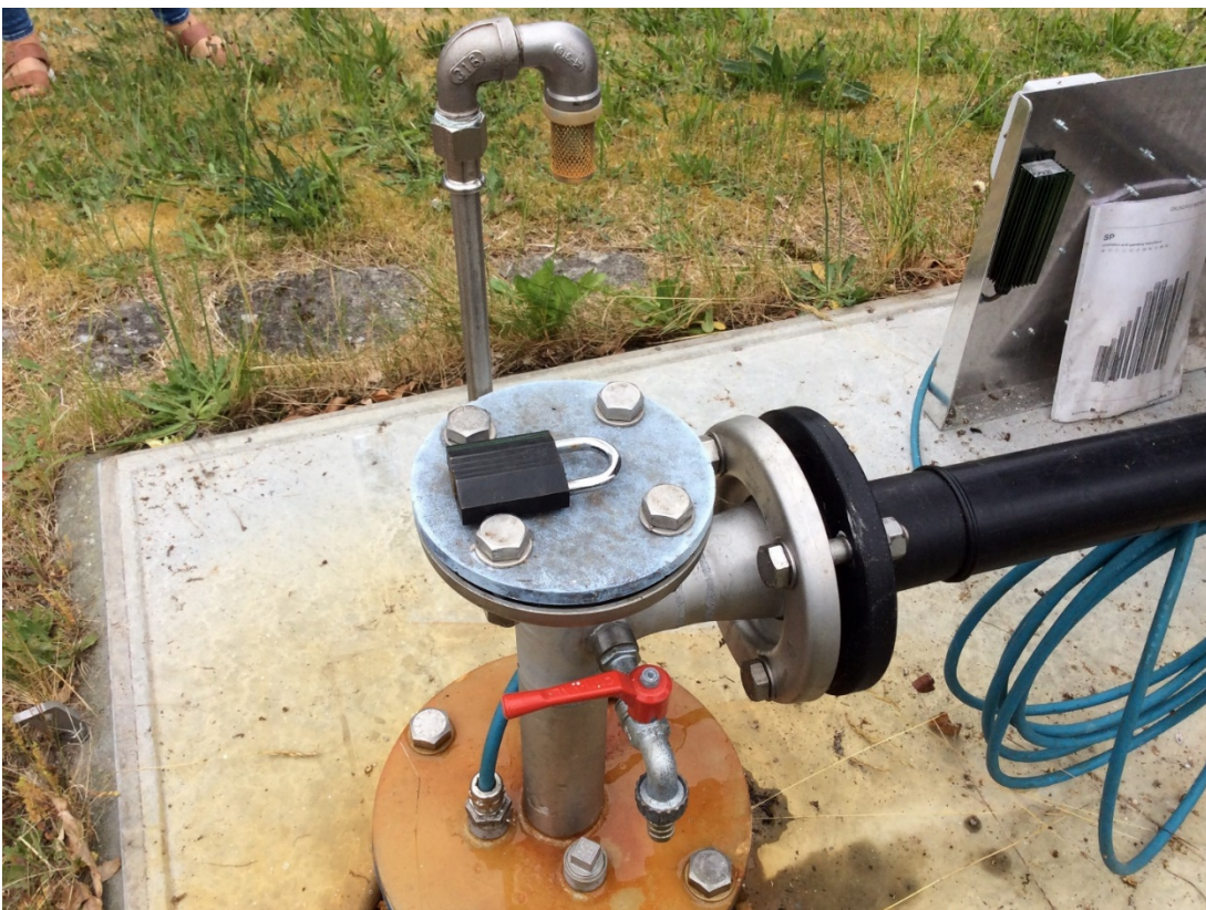
Udluftning med insektnet
