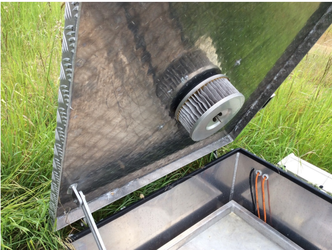
Pollenfilter i nedgangslem til rentvandsbeholderen
