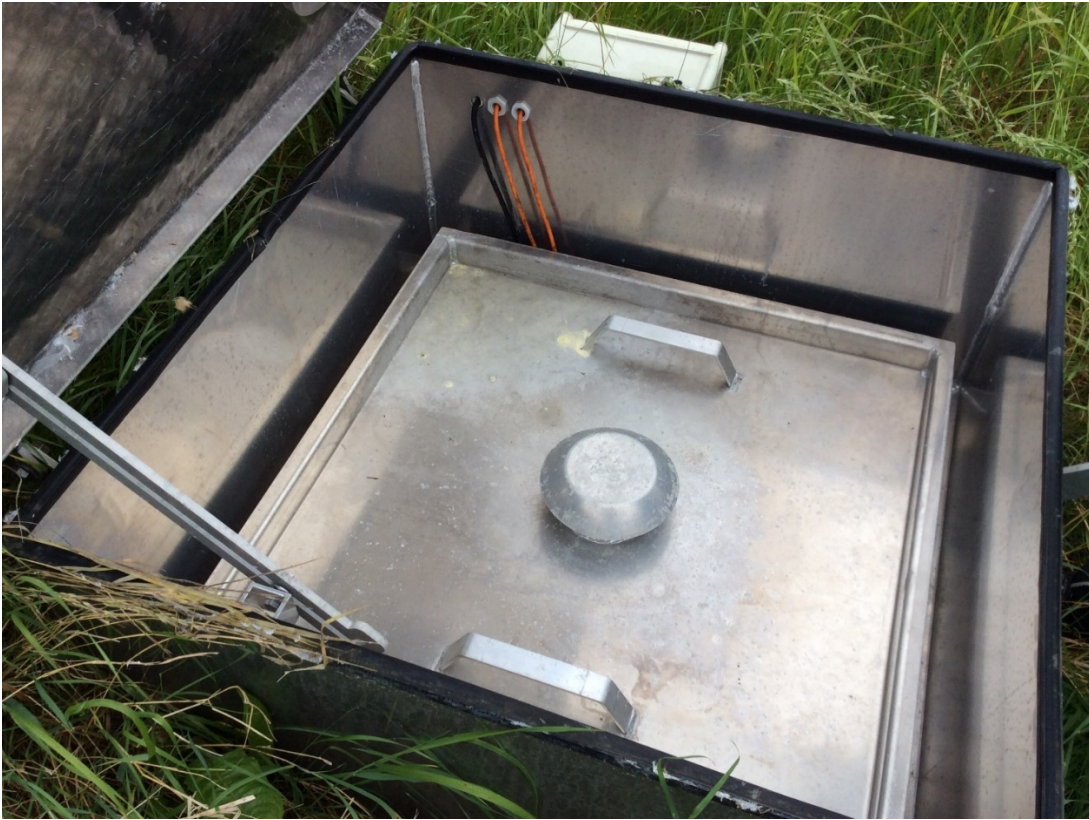
Dobbelt lem til rentvandsbeholderen
