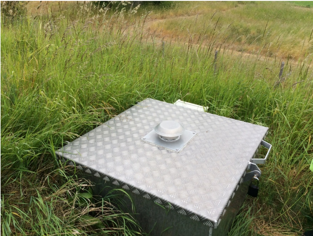
Nedgangslem til rentvandsbeholderen
